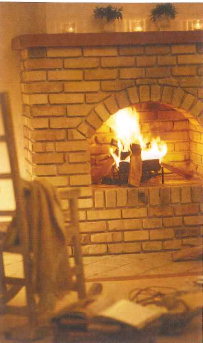
Fig. 9.24. Llar de foc construïda amb blocs de ceràmica refractària.
