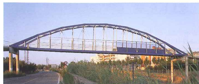
Fig. 9.30. Pont damunt la línia de l'AVE a Lleida, elaborat totalment amb perfils estructurals de material compost (fibres recobertes de resina polimèrica). S'aconsegueix molta rigidesa amb molt poc pes.
