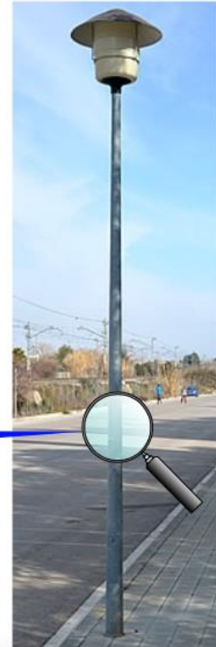
Fanal d'acer galvanitzat i ampliació que mostra els cristalls de zinc que es formen durant el bany en zinc fos.
