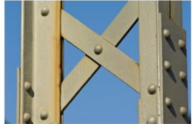
Detall d'una estructura antiga unida mitjançant reblons.
