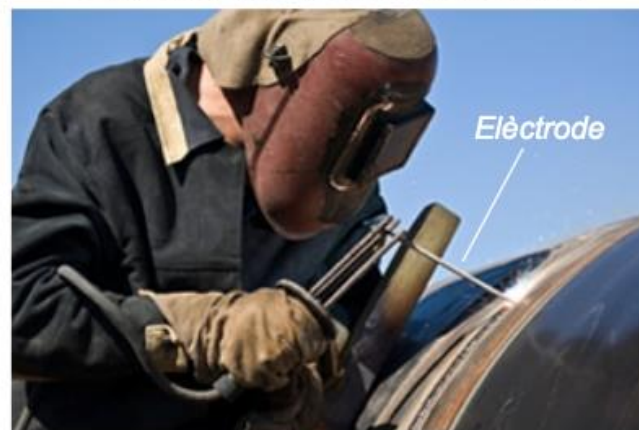
Soldadura d'una canonada.
