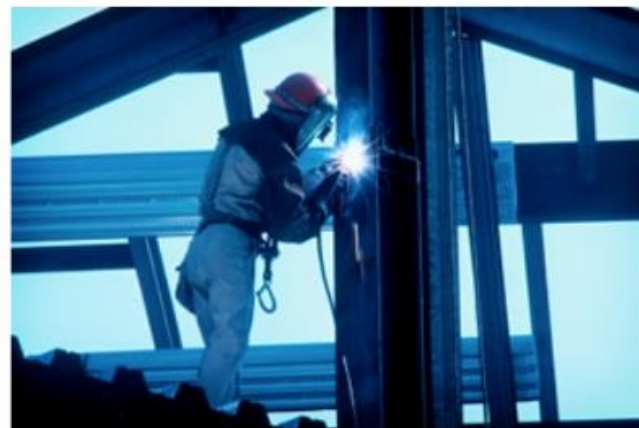
Soldadura de les bigues d'un edifici.
