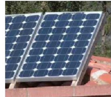
Un panell solar, format per 36 cèl·lules connectades en sèrie, instal·lat al terrat d'una casa.
