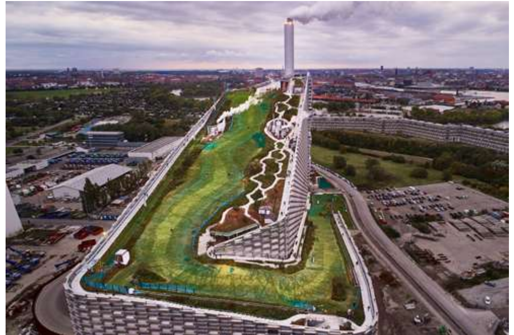
Amager Bakke, una planta que transforma els residus en energia i que substitueix una antiga planta incineradora de carbó, a prop de Copenhaguen. Dinamarca produeix suficient electricitat per abastir 60.000 habitatges i escalfar-ne 72.000. La tecnologia avançada de filtració redueix els nocius òxids de nitrogen gairebé a zero.
